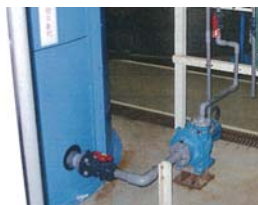
薬品配管フレキシ施工前
